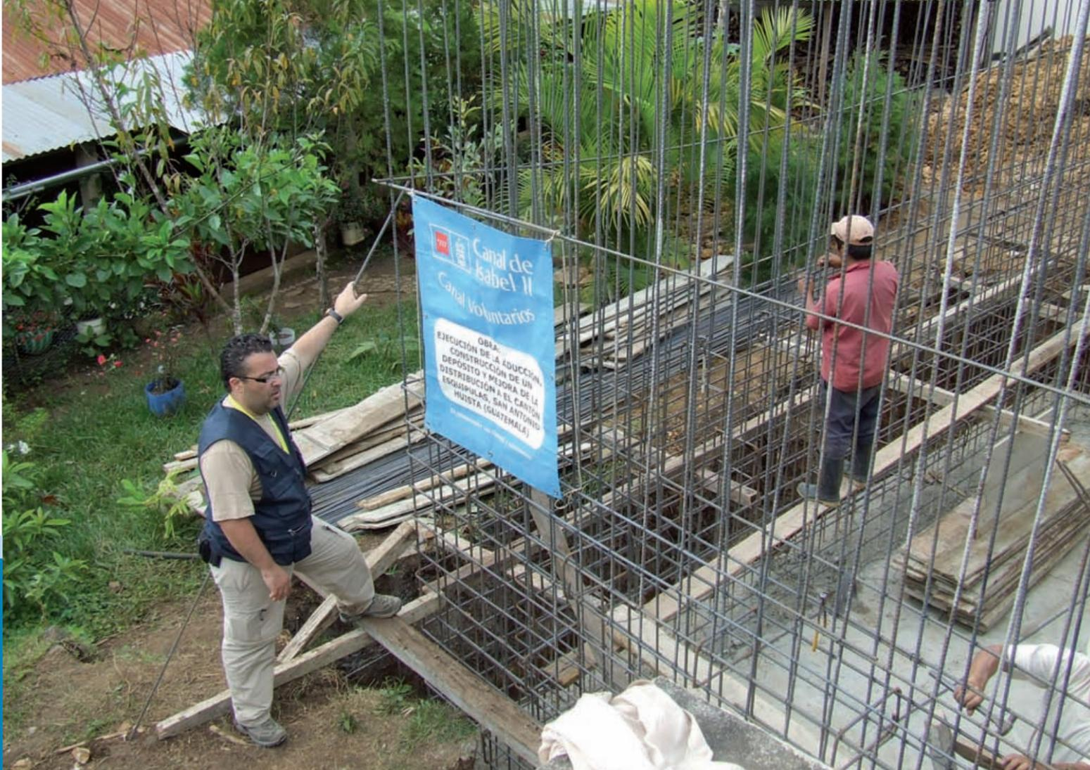
” Se ha llevado a cabo la construcción, de forma manual por los habitantes del cantón, de un depósito, una cámara de rotura y la instalación de la tubería de aducción
